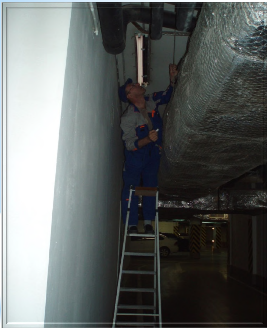
замена перегоревших ламп освещения на паркинге -2 уровня.
