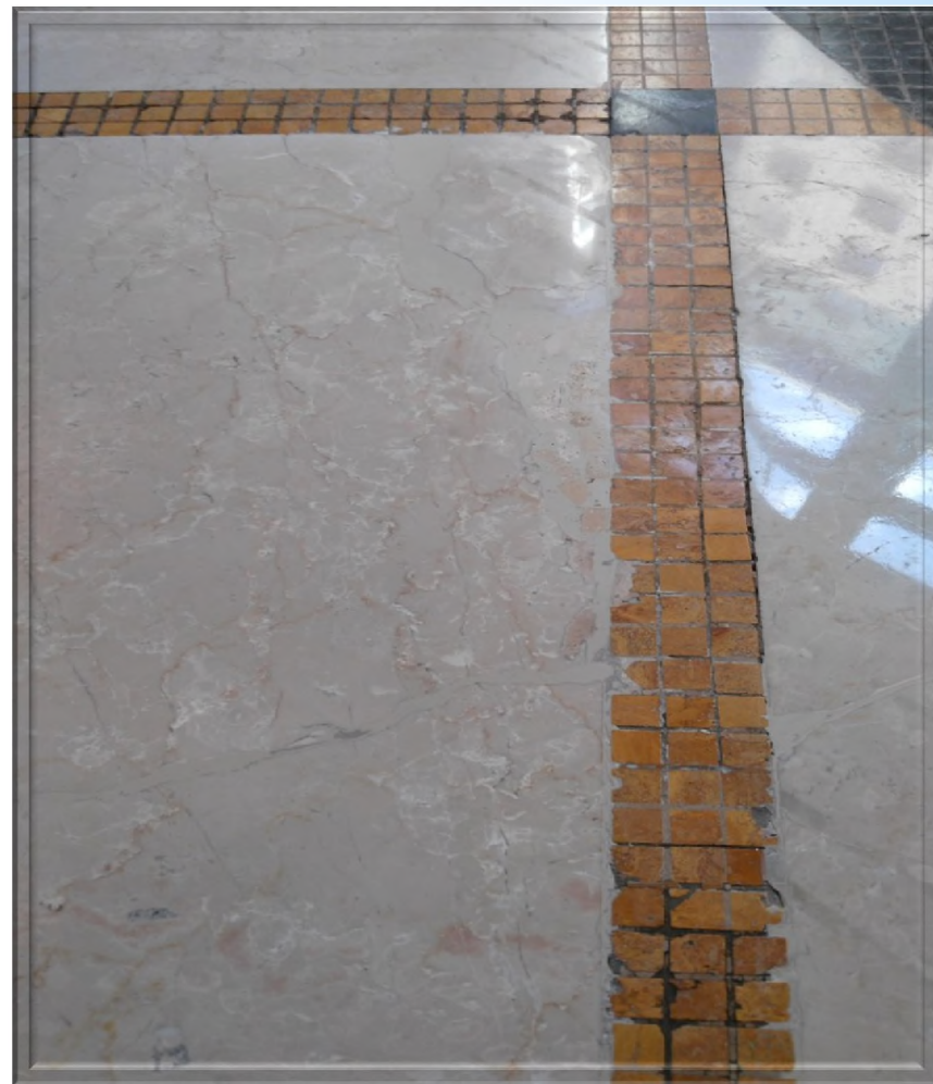
Трещина после ремонта
