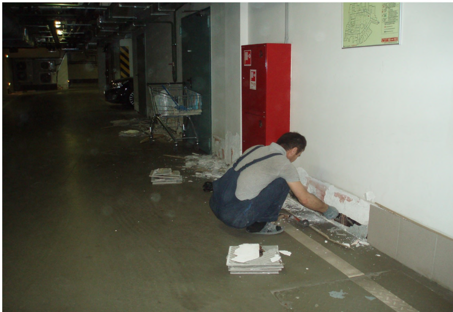
Съем старых плинтусных плиток паркинга -1 уровня
