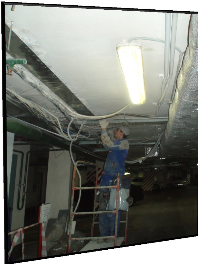
Ремонт гидроизоляции перекрытий паркинга- 1 уровня.
