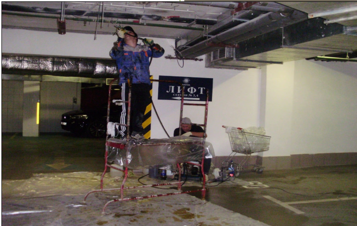
Ремонт гидроизоляции перекрытий на паркинге-2 уровня.
