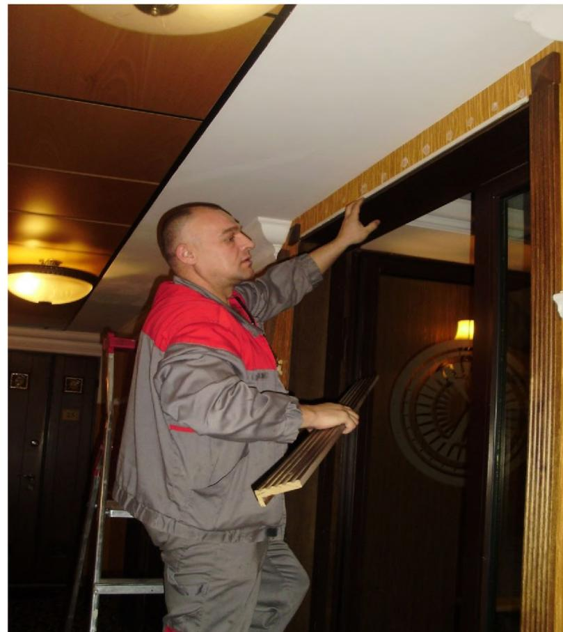
Изготовлены и установлены на потолке галереи 1 этажа в районе 4-ой секции два новых смотровых люка.
