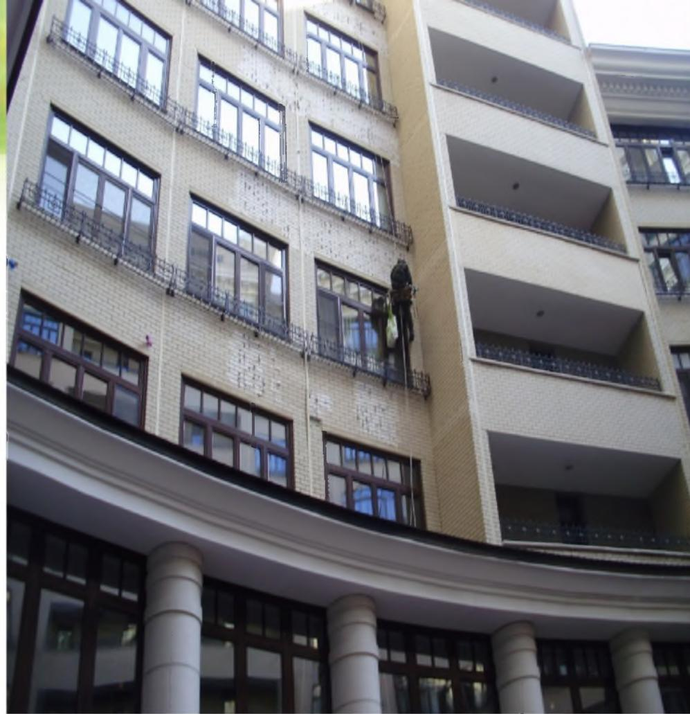
Аварийный ремонт плиточной облицовки фасада 3 секции со стороны внутреннего дворика
