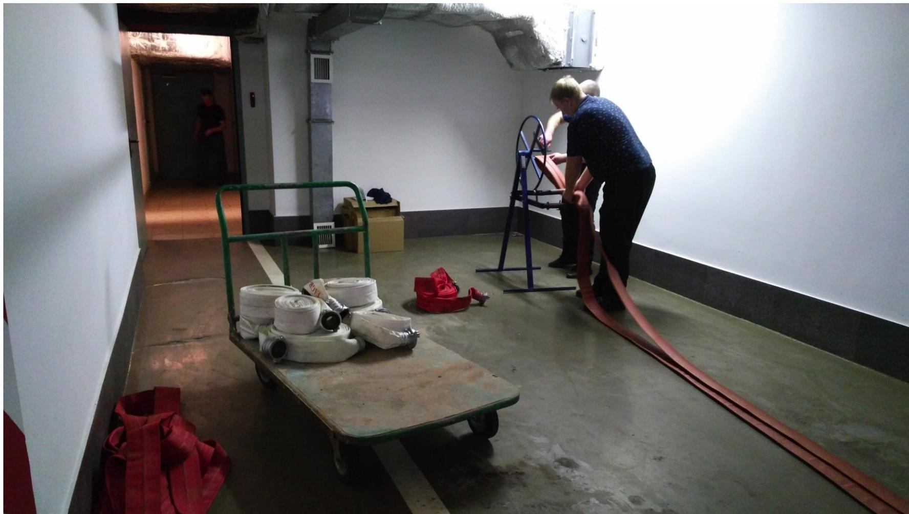
Выявлена новая протечка (5 п.м.) в перекрытии паркинга -2 уровня, которая была устранена путем инъекционной гидроизоляции фирмой ООО «Гидрострой».
