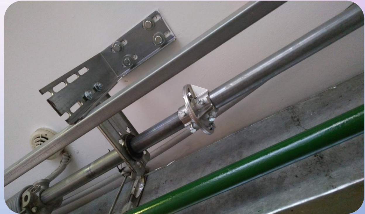
ремонт подъемных ворот
