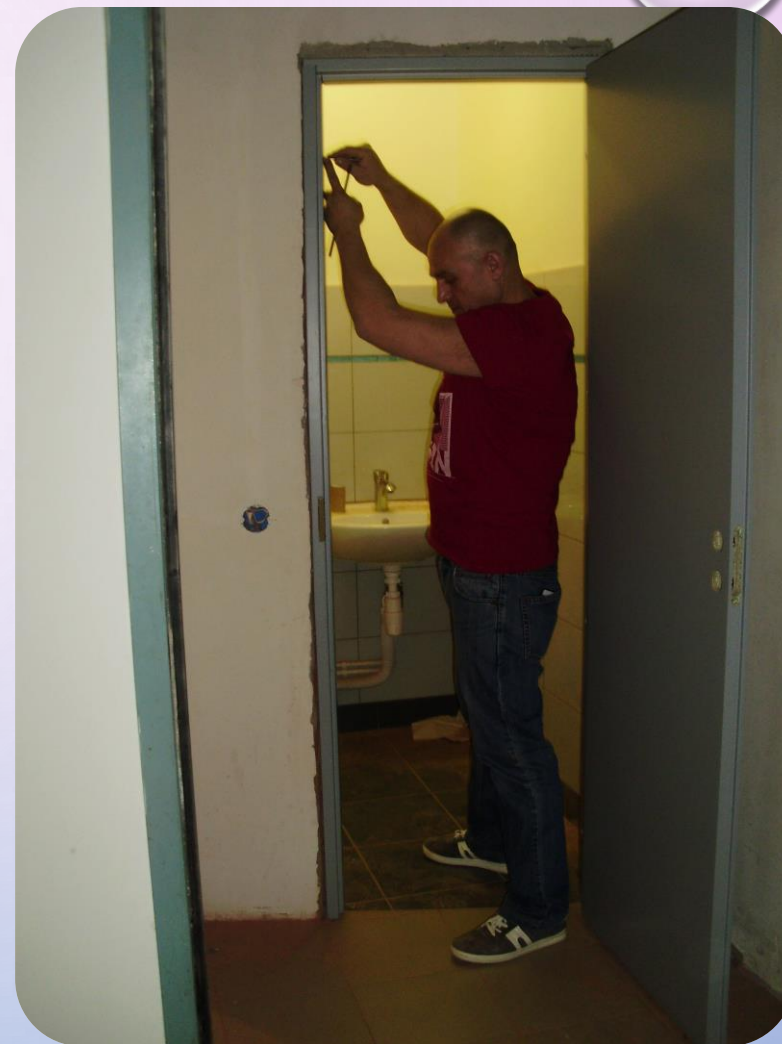
установка двери в новом туалете на паркинге -1 уровня
