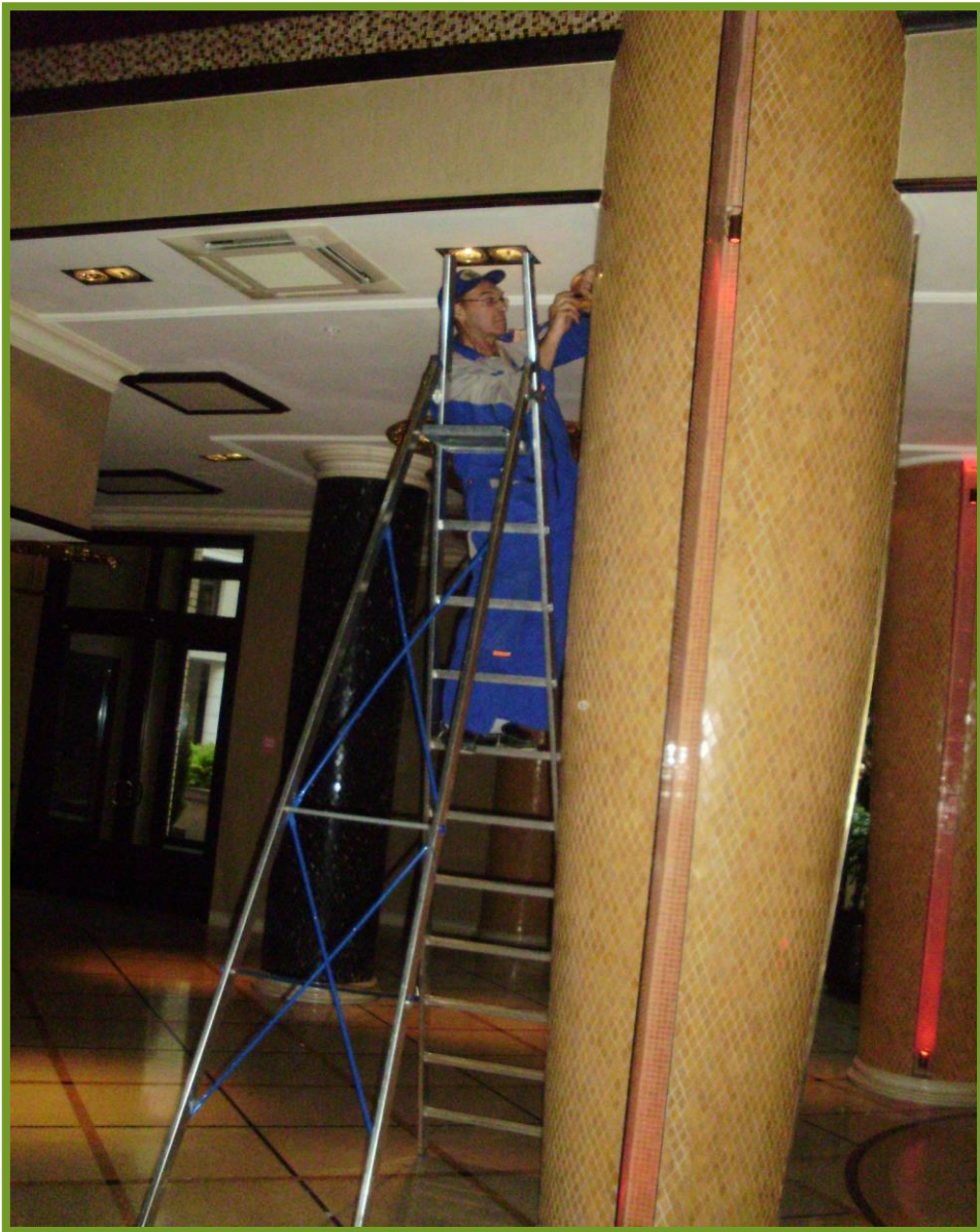
ремонт светильников- красный глаз — на колоннах входной группы
