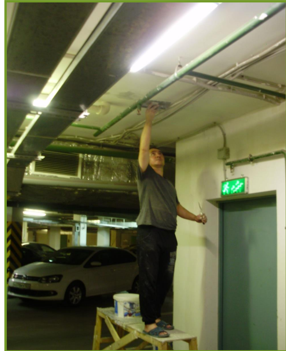
капремонт паркинга -2 уровня - затирка потолков
