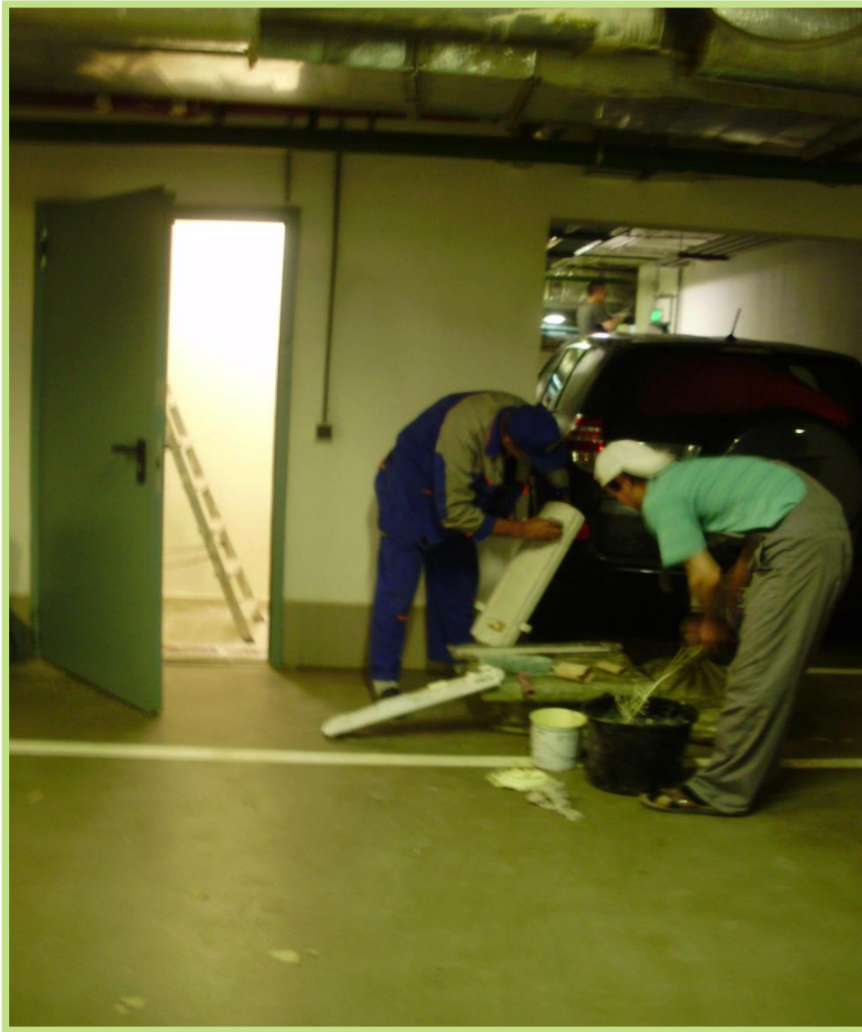
ремонт помещения после протечки с заменой светильника на светодиодный
