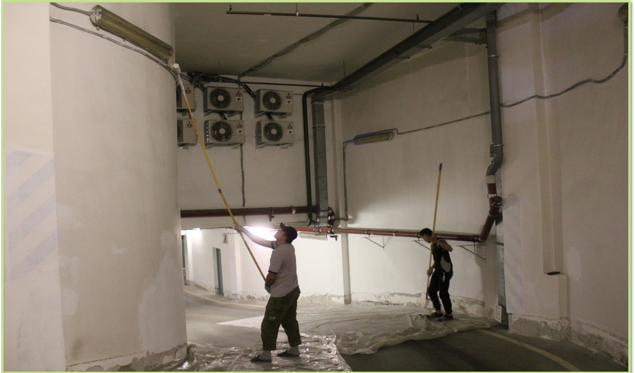
капремонт паркинга -2 уровня
