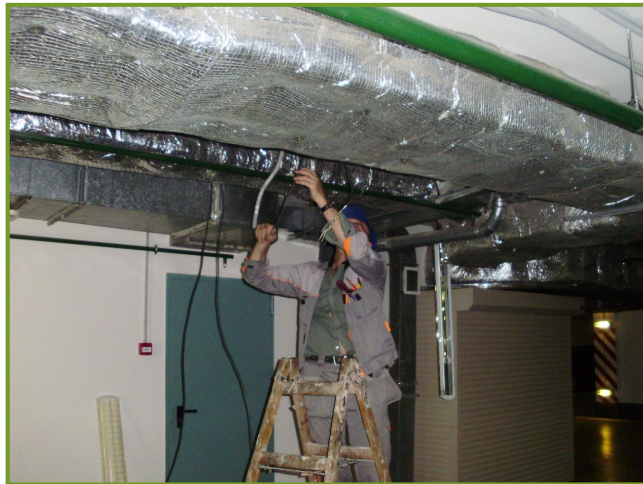
протяжка нового кабеля к светильнику на -1 паркинге
