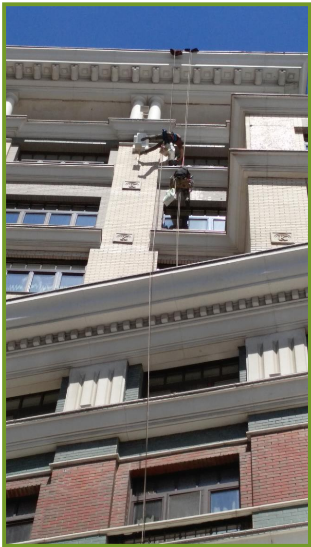
работают альпинисты ремонт фасада 6 секции
