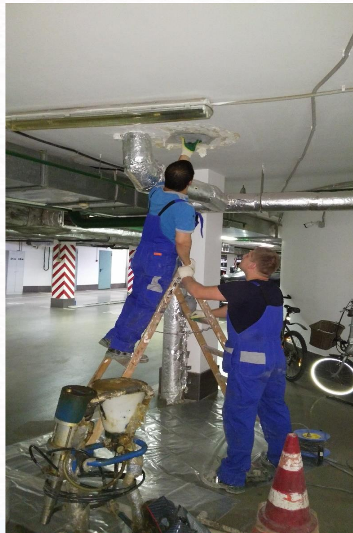
инъекционная гидроизоляция отверстия в перекрытии -1 паркинга
