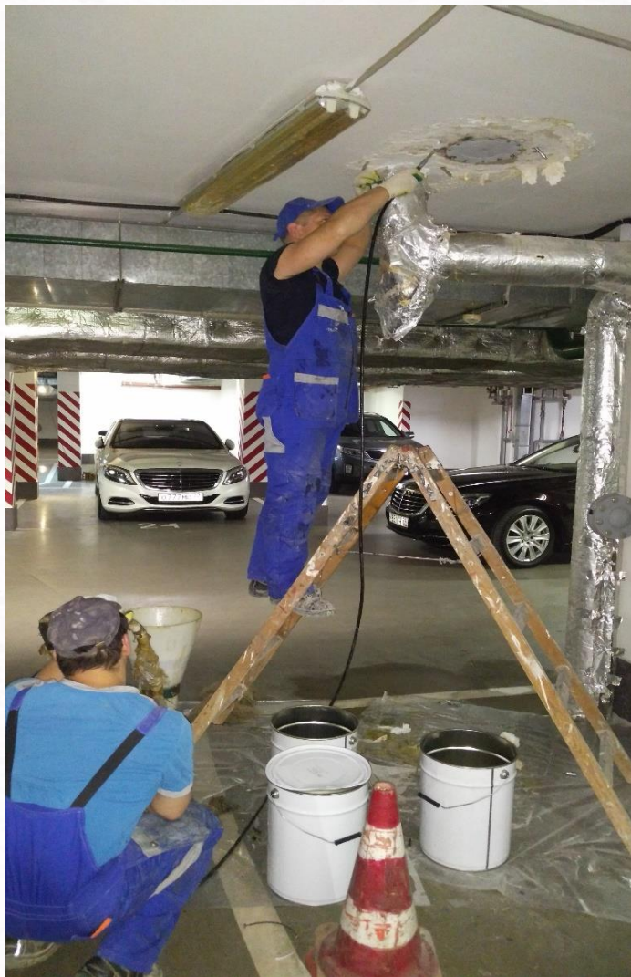
инъекционная гидроизоляция отверстия в перекрытии -1 паркинга
