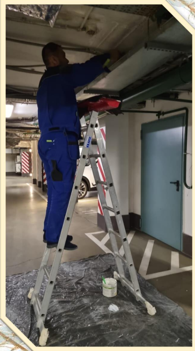
Ремонт потолка парковки -1 уровня.
