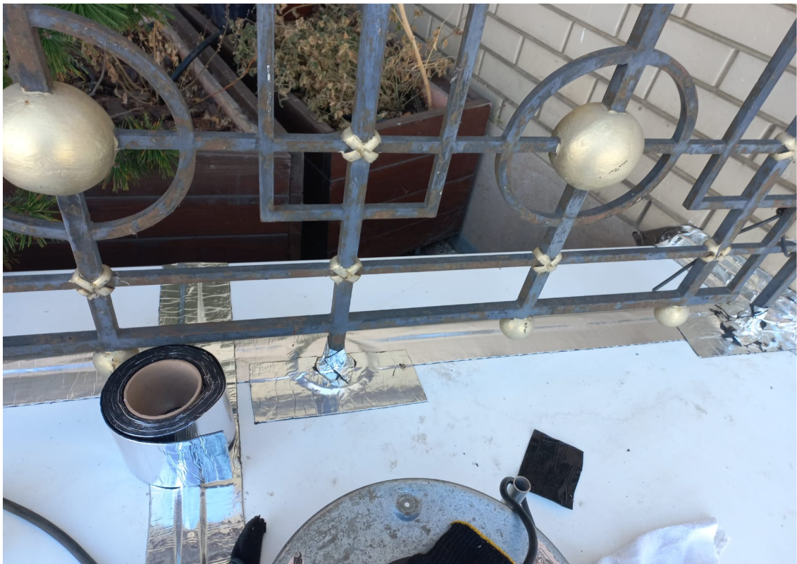
Герметизация парапетов 4 секция 7й этаж
