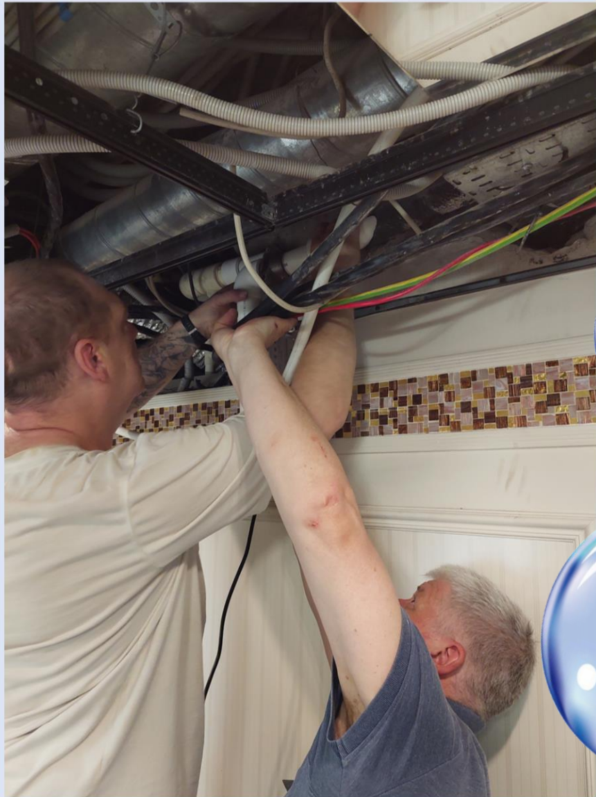
Замена участка трубопровода 1 секция
