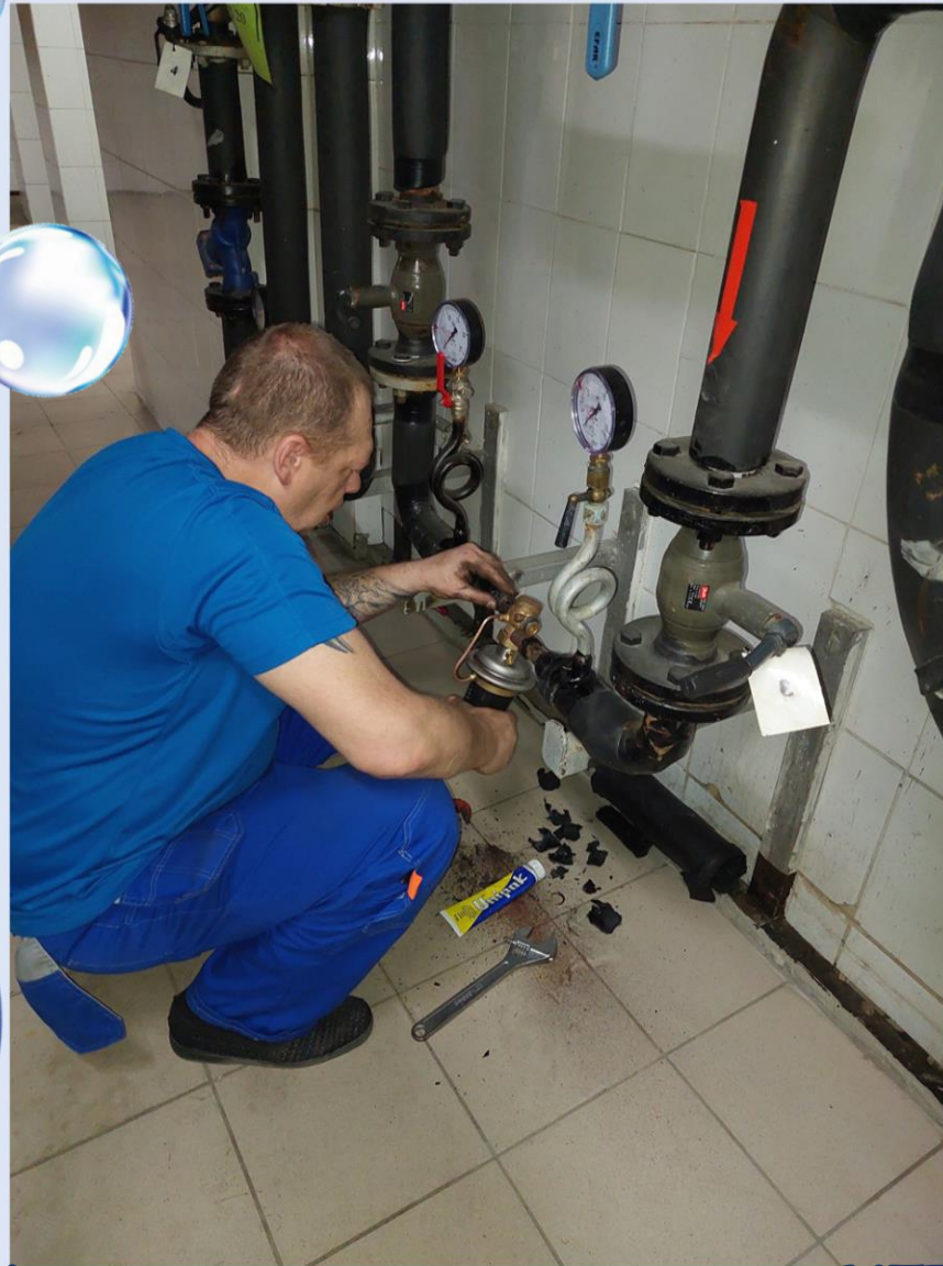
Установка регулятора давления ИТП
