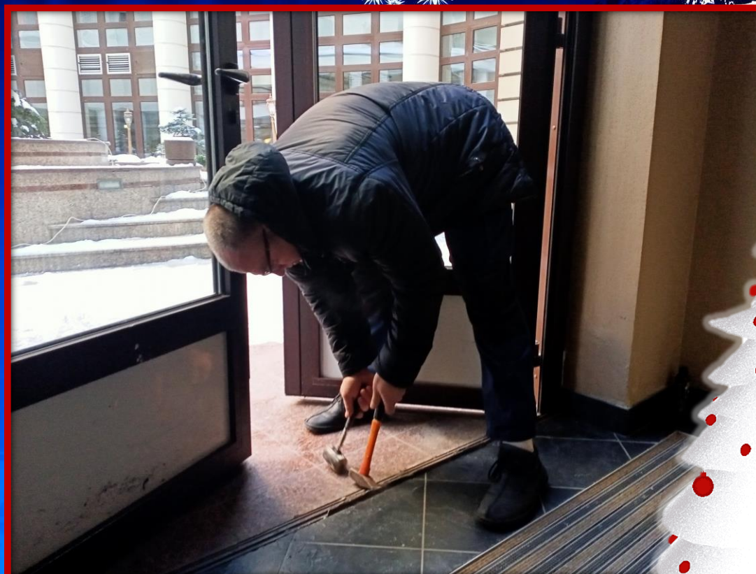
Ремонт дверей внутреннего двора
