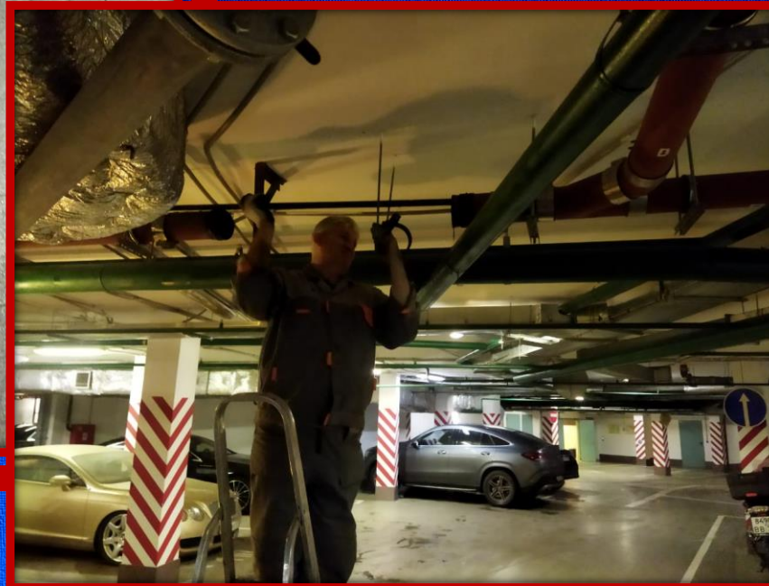
Замена части трубопровода канализации
