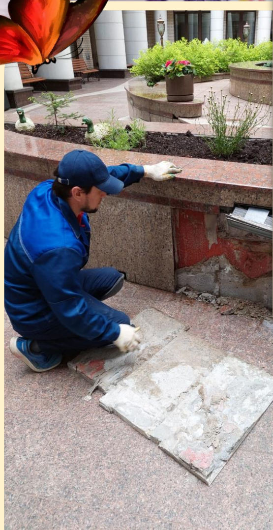
Ремонт плиточного покрытия внутреннего двора
