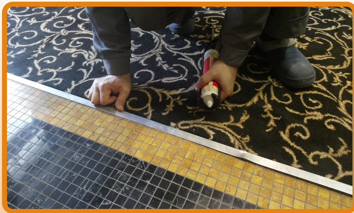
Ремонт накладки 3 секция 6 этаж
