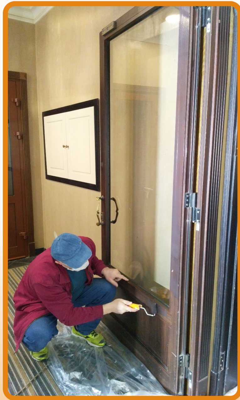
Ремонт поврежденной двери внутреннего дворика 4-я секция
