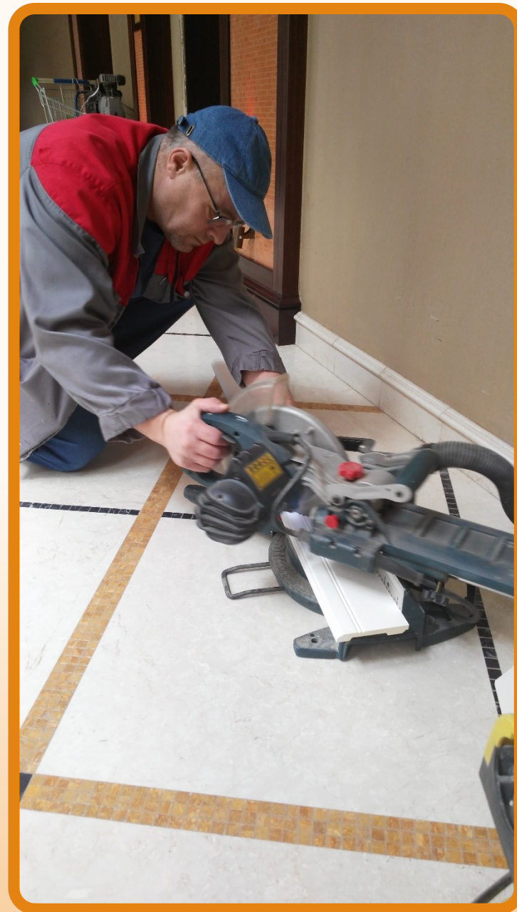
Ремонт наличника портала 4-ой секции
