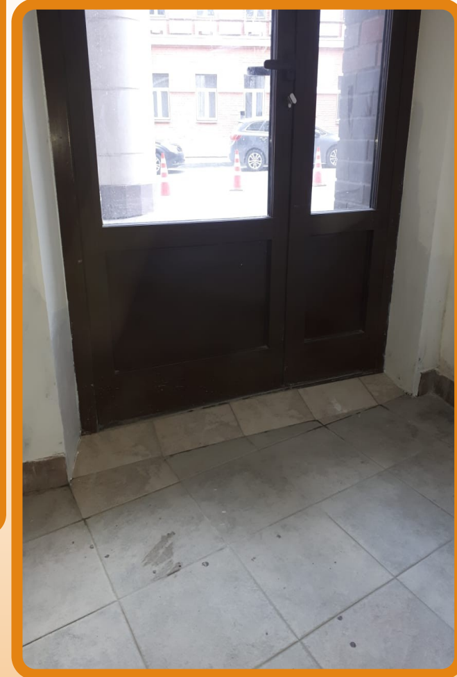
Ремонт плиточного покрытия на выходе из паркинга 3 секции
