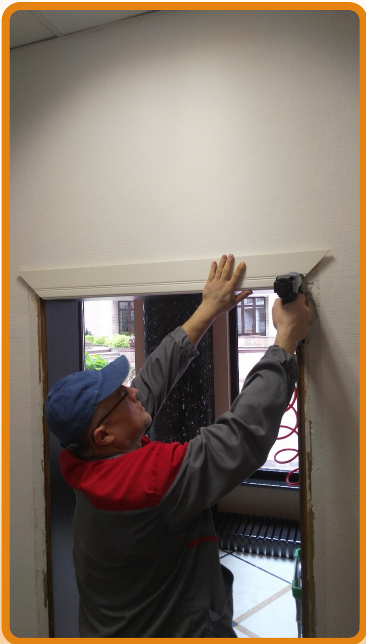
Ремонт наличника портала 4-ой секции
