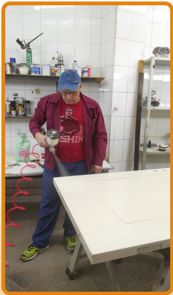
Покраска входной двери в офис ТСЖ
