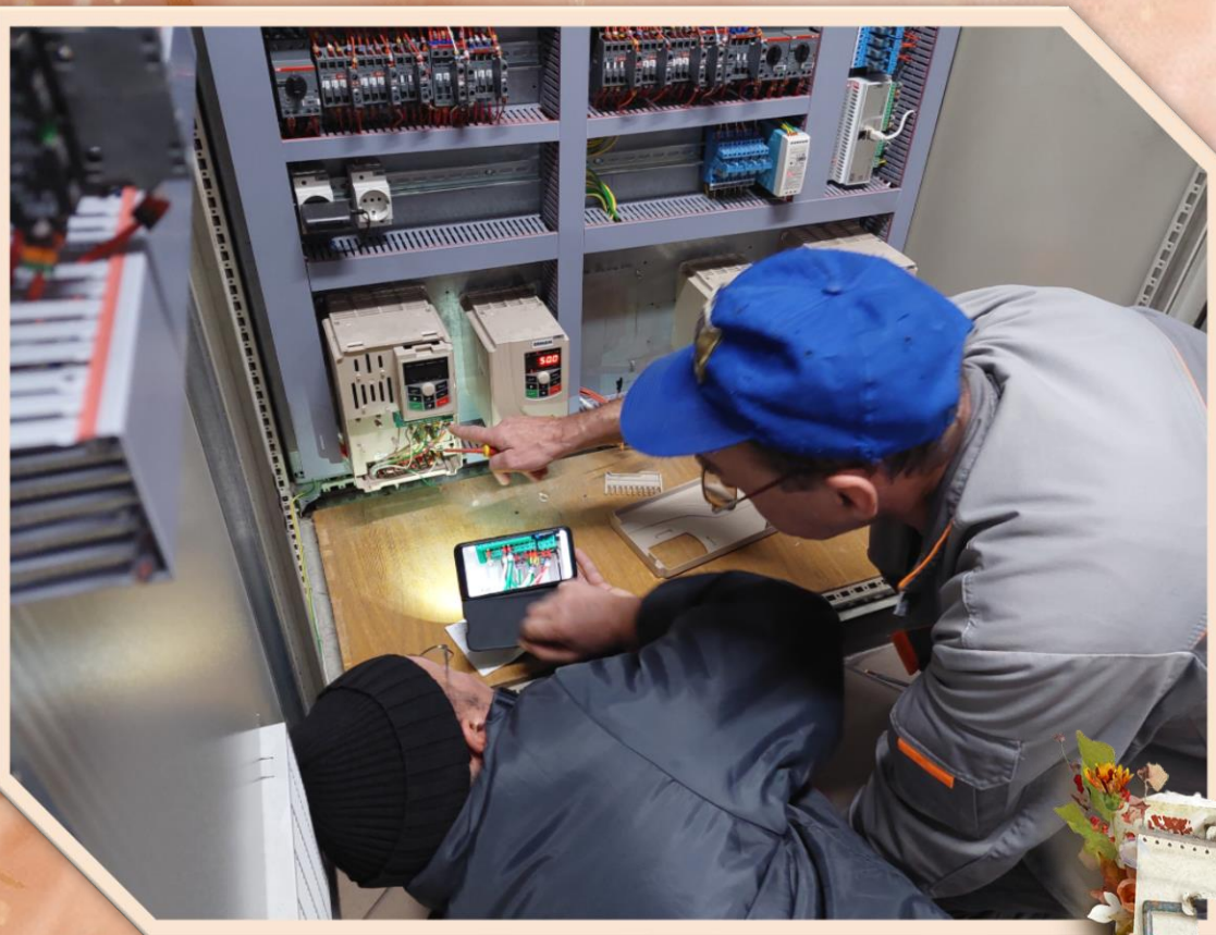
Ремонт частотного преобразователя насосов рециркуляции ГВС жилья в шкафу автоматики ИТП
