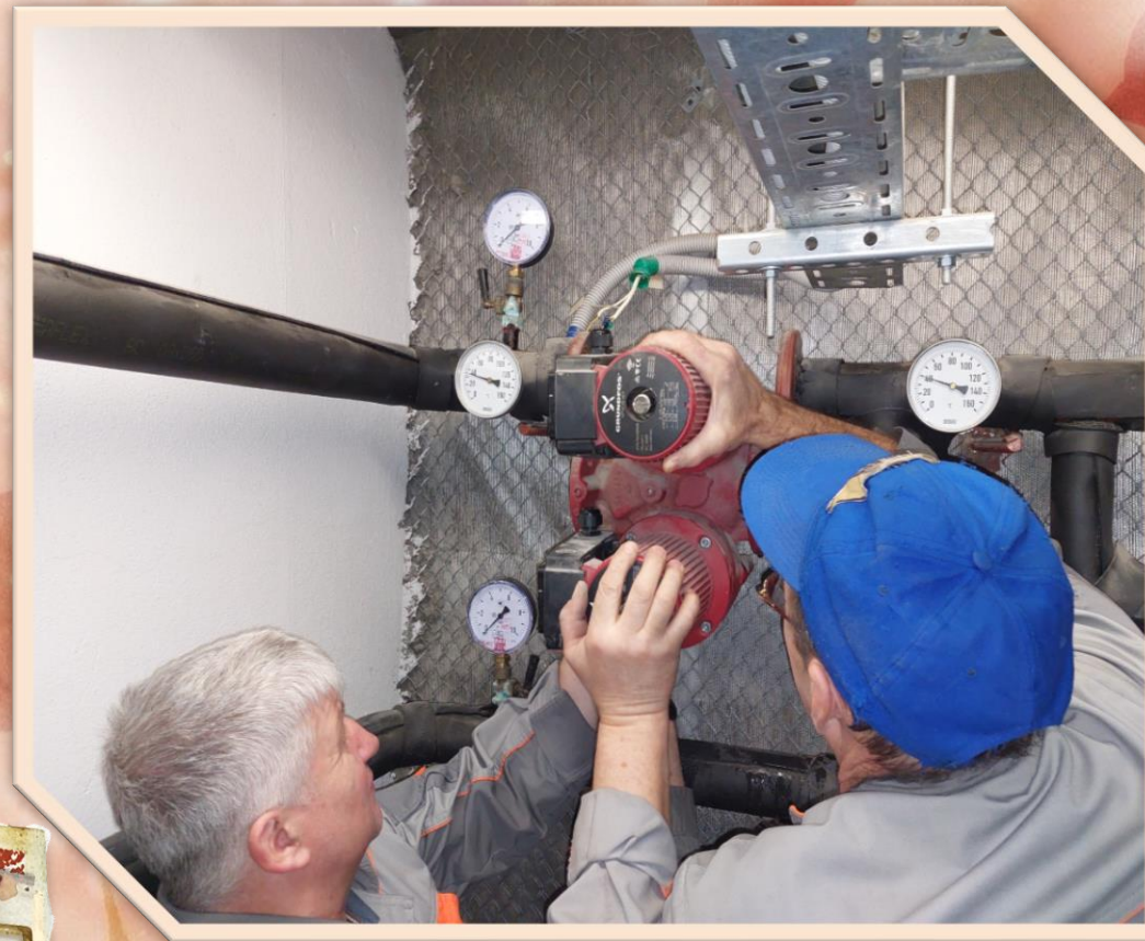
Замена циркуляционного насоса вентустановки жилой зоны 4 секции
