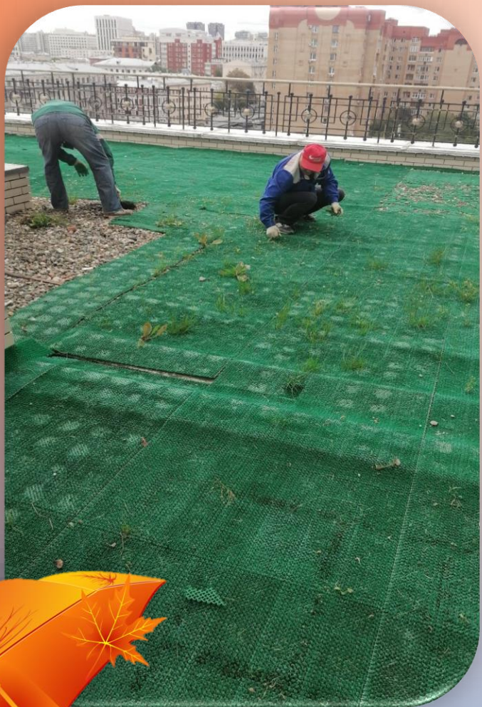
Уборка кровли от растений
