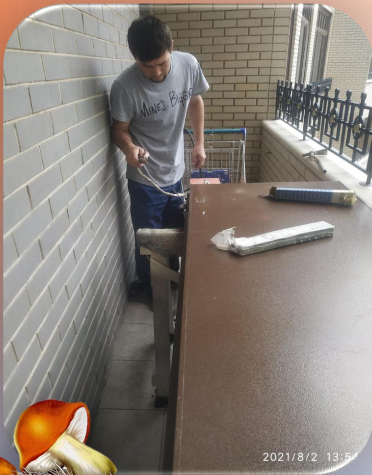
Ремонт петли двери мусорокамеры
