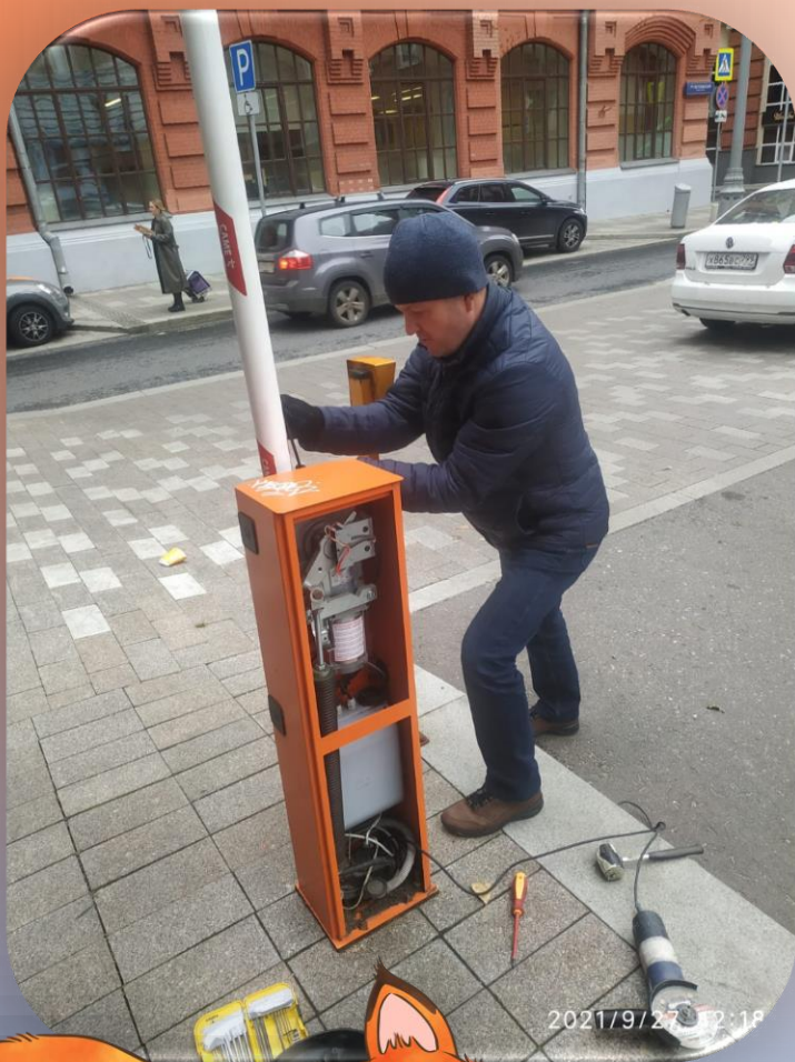
Ремонт стрелы шлагбаума
