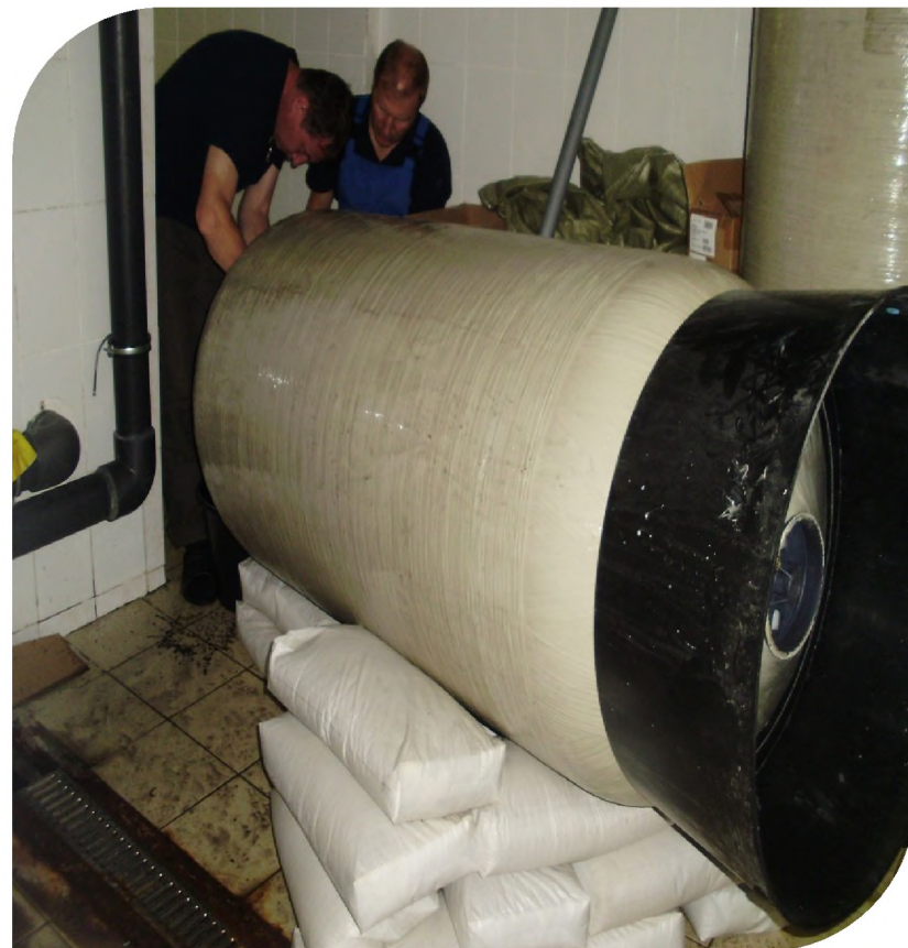
подготовка танка к выгрузке старого фильтр материала и дезинфекции
