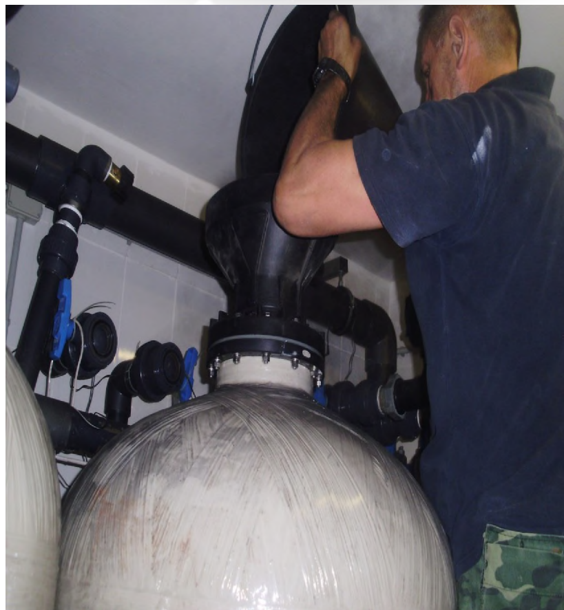
засыпка в танк нового фильтрующего материала
