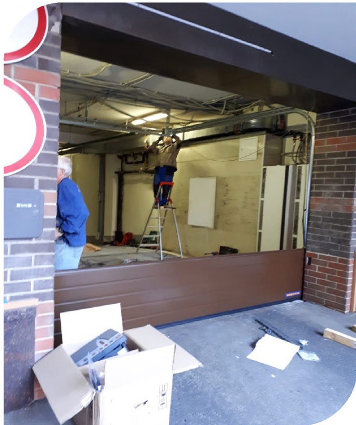
монтаж въездных ворот паркинга -2 уровня
