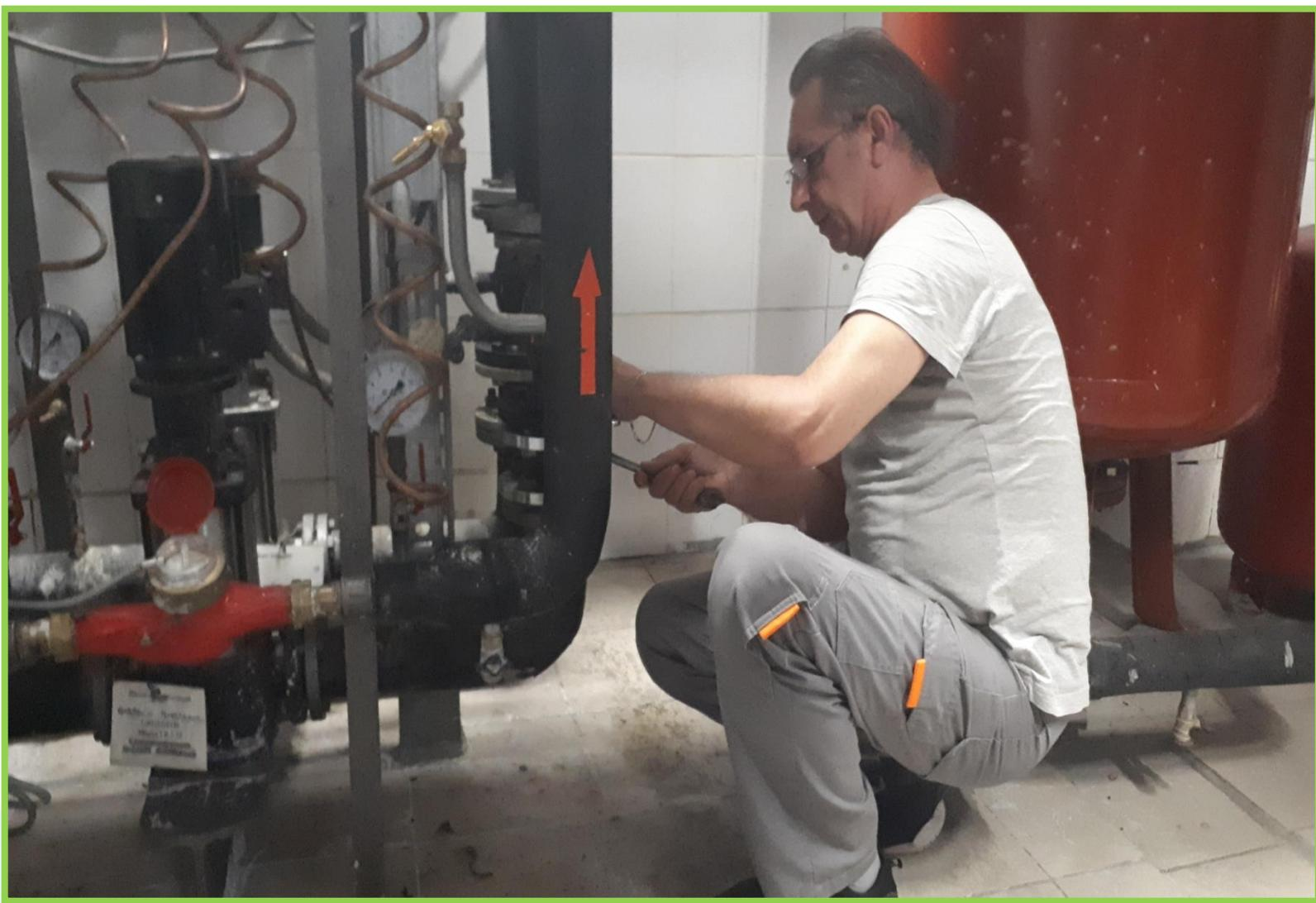
*Замена вибровставки на трубопроводе узла подкачки теплоносителя в ИТП;*
