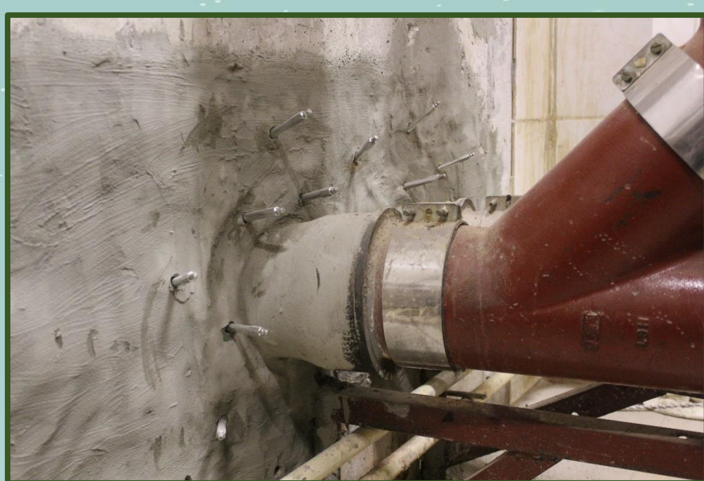
Участок стены с протечкой подготовлен для проведения инъекционной гидроизоляции
