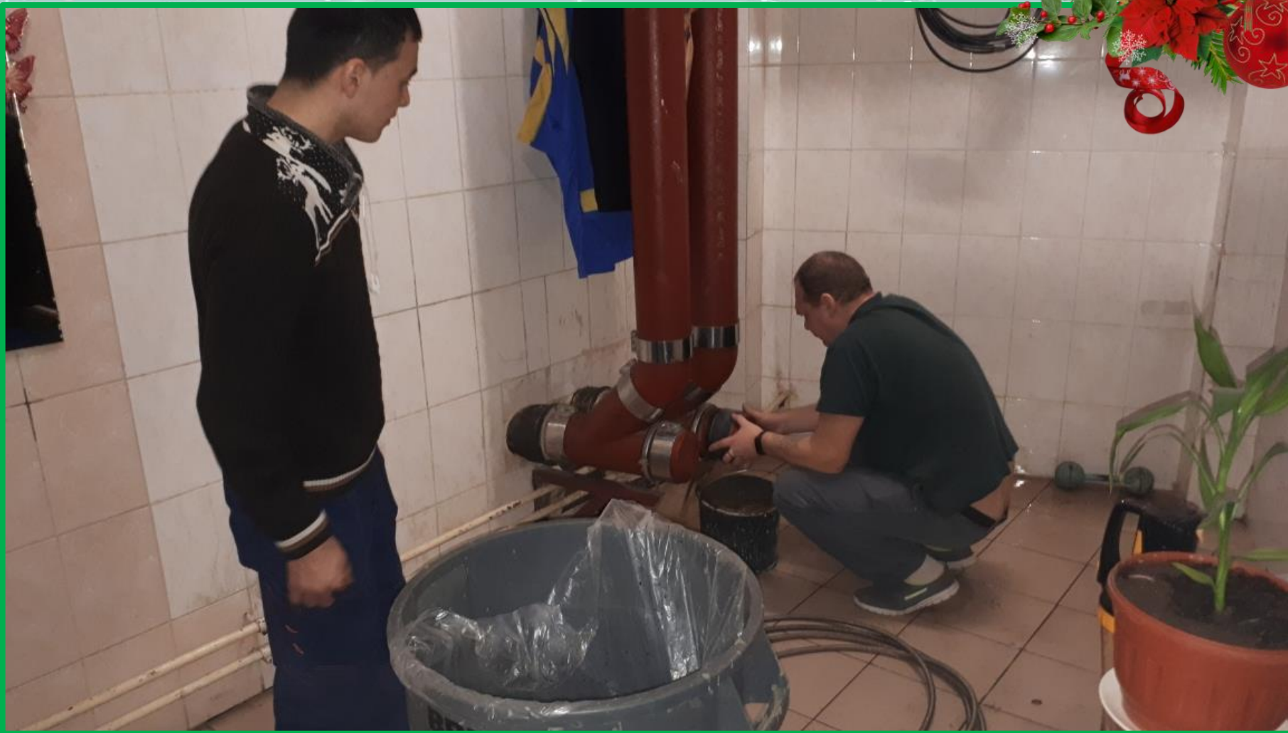
Прочистка канализационной трубы
