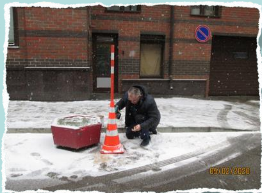
восстанавливаем сорванную автомобилем стойку-ограничитель
