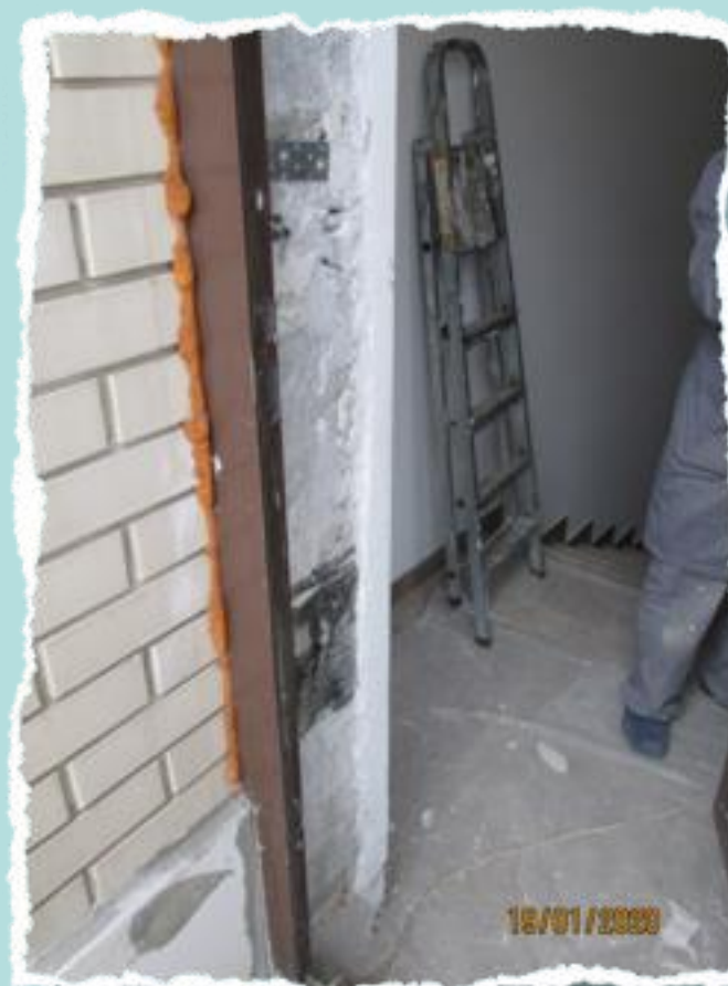
отремонтированные откосы дверей 12 этажа 4-ой секции
