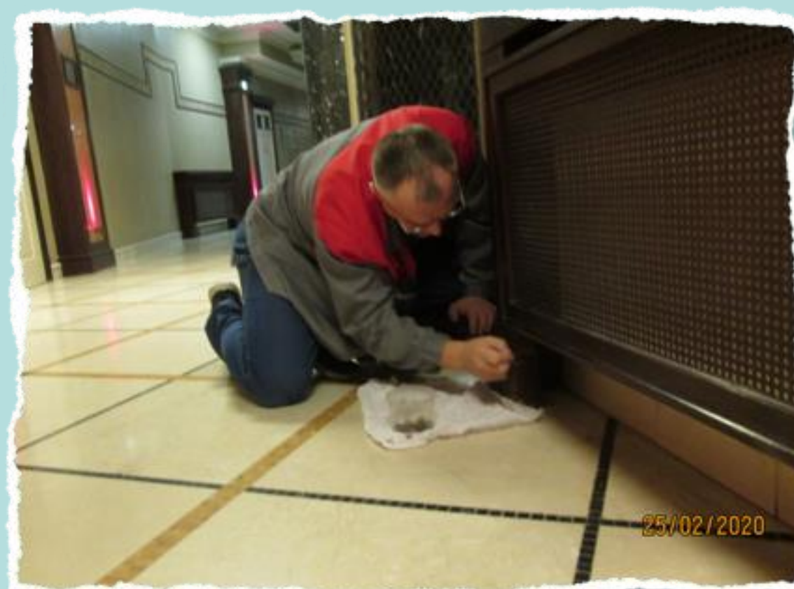
ремонт экрана батареи отопления
